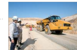
重ダンプによる造成工事(宮城県東松島市)
