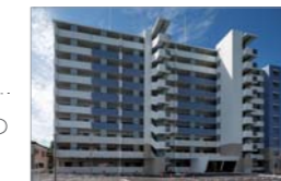
市営四反田住宅(宮城県気仙沼市)
