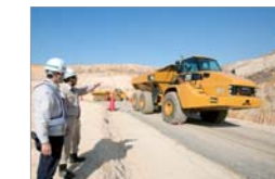
重ダンプによる造成工事(多賀城市)
