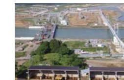
大量土の搬出のため設置された ベルトコンベヤー(陸前高田市)
