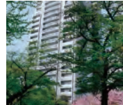
文京グリーンコートビュータワー本駒込
