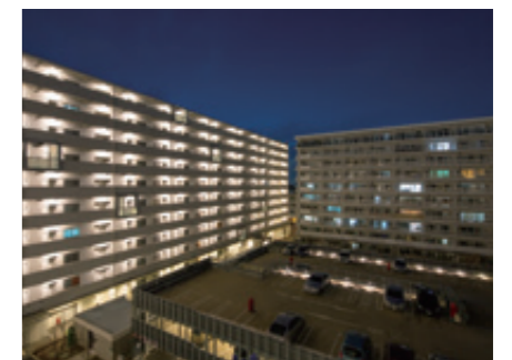
光源が見えないよう配慮した駐車場
