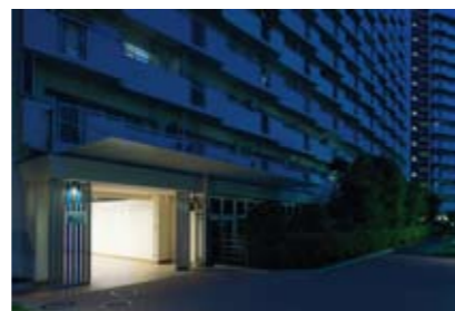
生まれ変わった住棟エントランス
