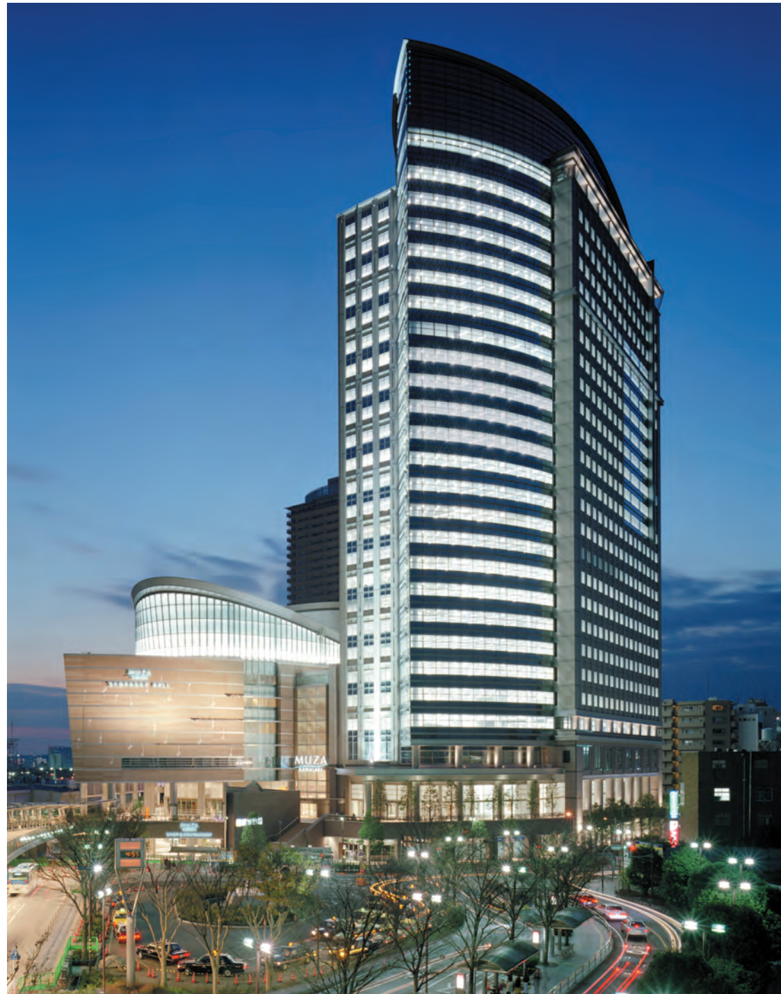
川崎駅西口の顔をつくる景観照明
