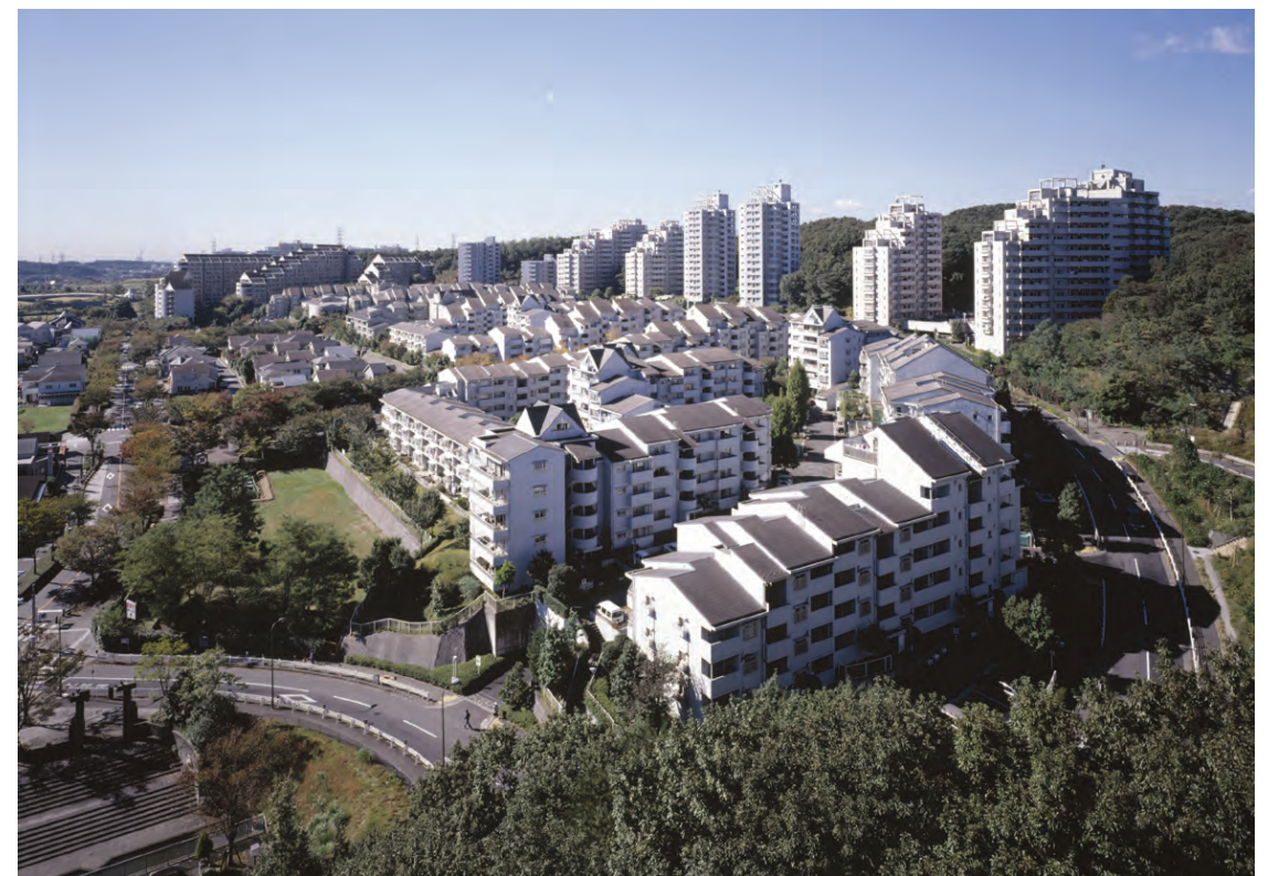
多摩NTファインヒルいなぎ向陽台 1998 稲城市
