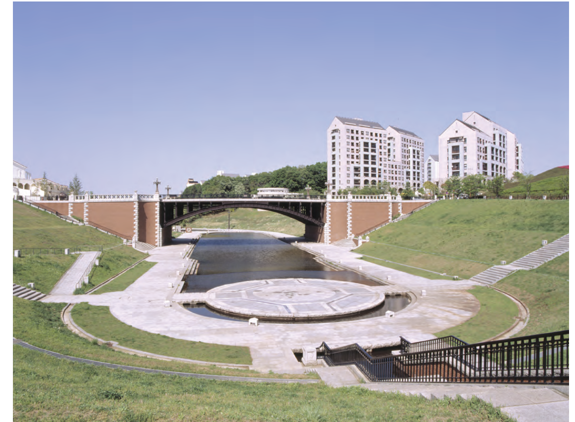
移築復元された長池見附橋
