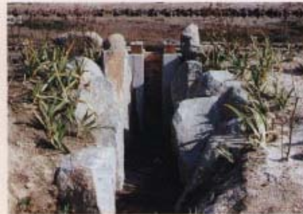
◀かい張りができるように、水を抜くための樋門を設ける。
