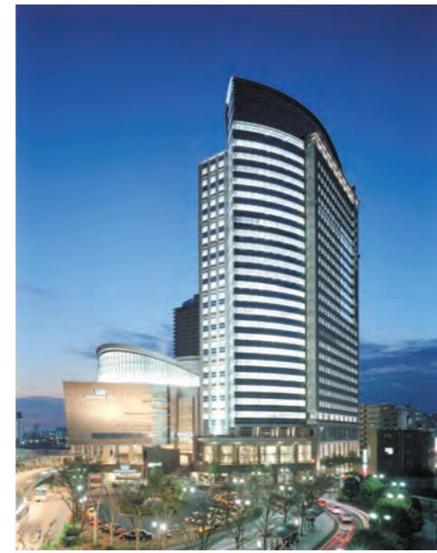
川崎駅西口の顔をつくる景観照明
