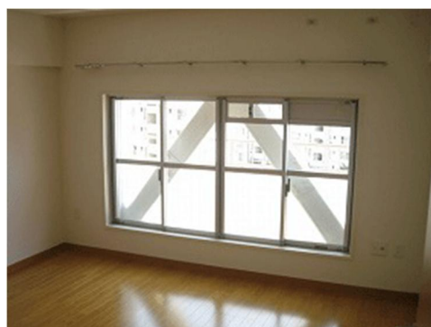
住戸バルコニー側の補強（室内から）
