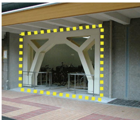
鉄骨ブレース（破線部分）
