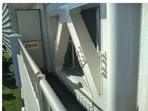
住戸バルコニー側の補強
