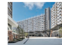
洋光台中央 広場改修
