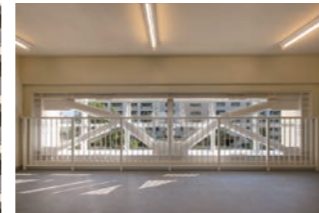
鉄骨ブレース(共用廊下より)
