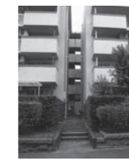
階段室1階部分の通り抜け空間
