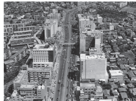
青山通りの地区市街地住宅
