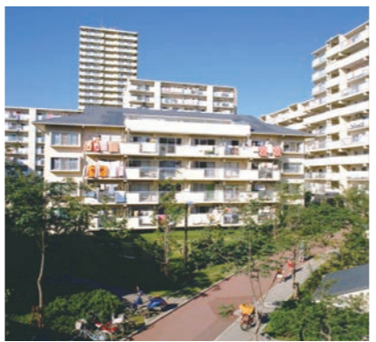
勾配屋根の4階住棟の間を走る主要歩行動線
