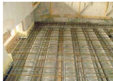
▲大型スラブ配筋
