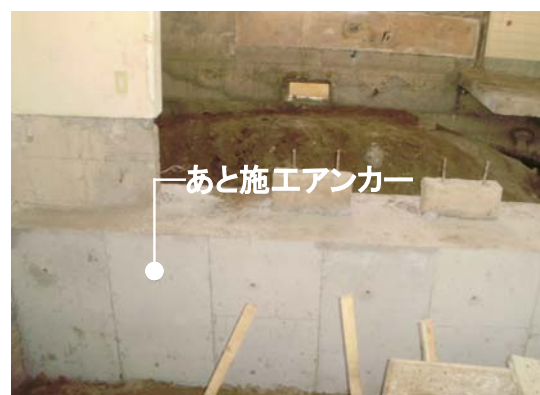
▲あと施工アンカー接合
