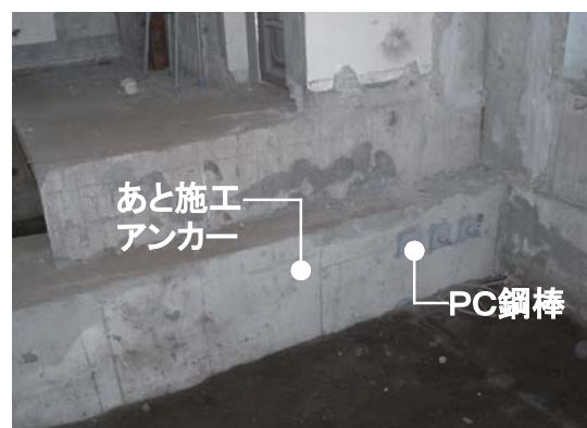
▲あと施工アンカー接合+PC鋼棒圧着
