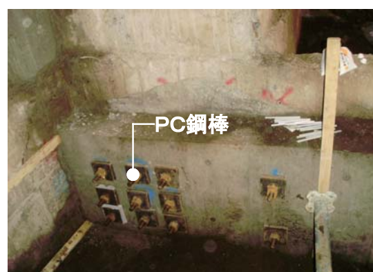
▲PC鋼棒圧着
