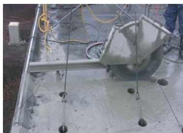
ウォールソーによる屋根の解体
