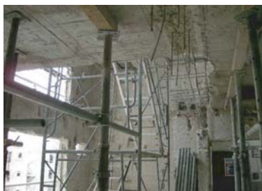
吹き抜け部分のコンクリート床撤去
