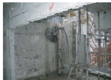
ウォールソーによる外壁の解体
