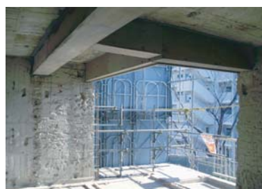
テラス新設部のコンクリート梁補強
