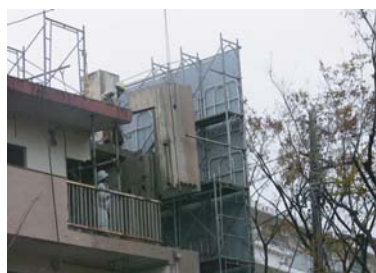
クレーンによる解体部材の撤去
