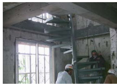
吹き抜け開口補強梁
