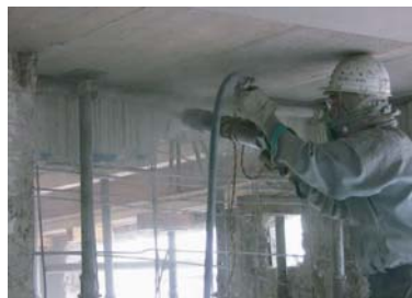
ブレイカーによる解体
