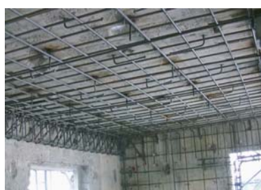
既存スラブ下部に配筋
