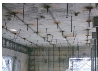
既存スラブ下部に差筋
