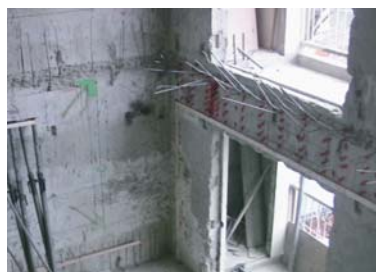
既存スラブ解体
