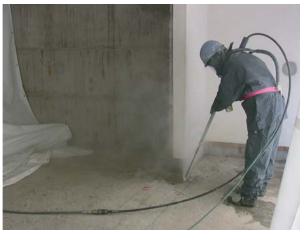
ウォータージェットによる袖壁の解体
