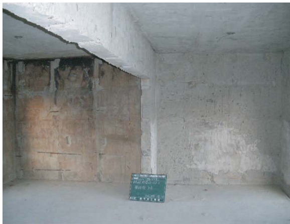
既存壁梁・袖壁
