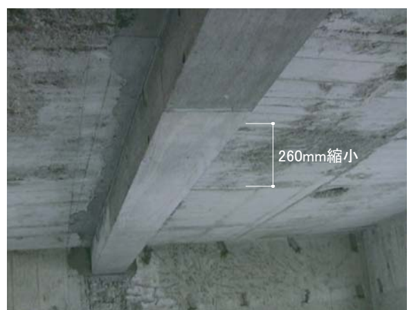
扁平梁コンクリート打ち完了
