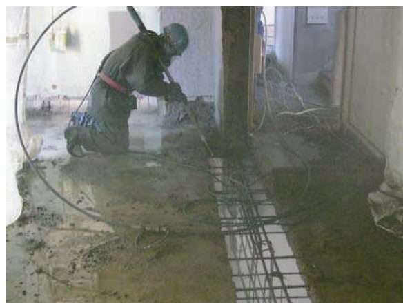
ウォータージェットによる壁梁の解体
