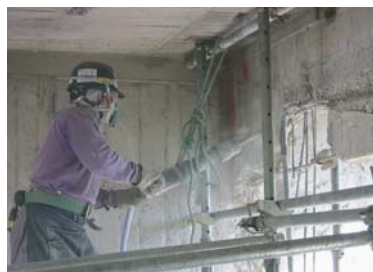
ブレーカーによる壁梁解体
