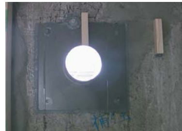
配管スリーブ鉄板補強後
