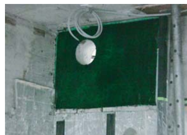
配管スリーブ炭素繊維シート補強後
