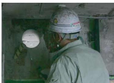
配管スリーブ炭素繊維シート補強施工
