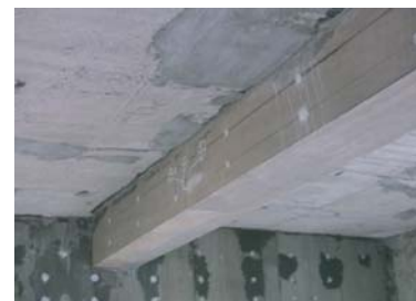
新設扁平梁施工完了
