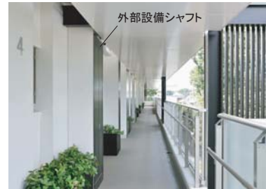
外部設備シャフト
