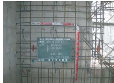
コンクリート増し打ち配筋
