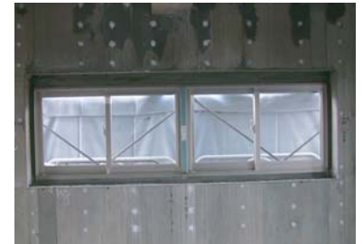
コンクリート増し打ち完了
