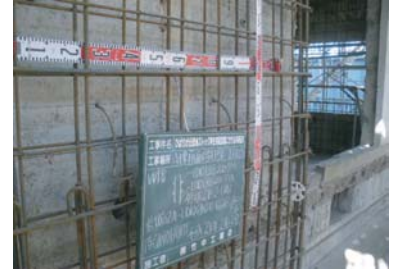
南側外壁の増し打ち補強
