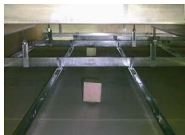
天井裏におもり(制振装置)設置
