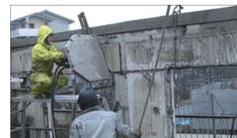
4 4階壁梁の解体
