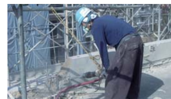
5 切断端部の補強・補修
