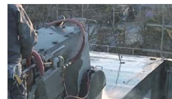
3 既存屋根の大割解体
