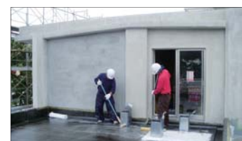
6 屋根防水工事
