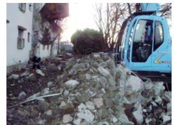
解体後のコンクリートガラ
