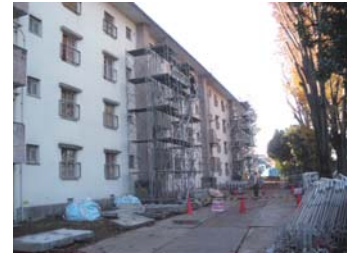
1 準備工事・工事足場
