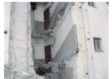
切断面の状況
