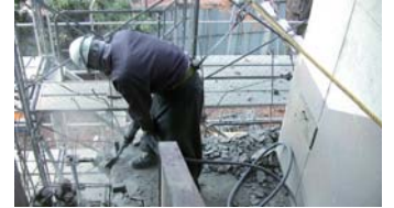
2 ブレーカーによる解体
