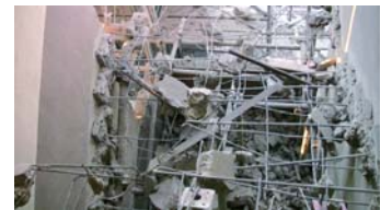
切断面の状況(端部処理前)
