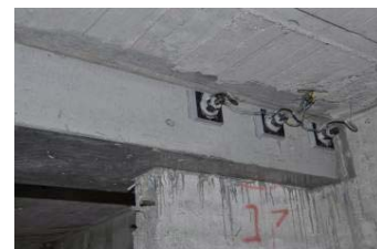
7 PC鋼棒緊張後
