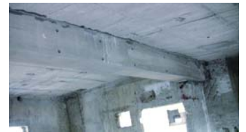
6 コンクリート打設後
