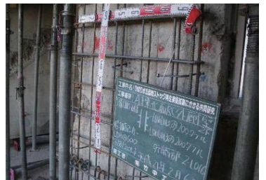
4 増打ち耐力壁の配筋
