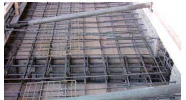
5 4階スラブ配筋
