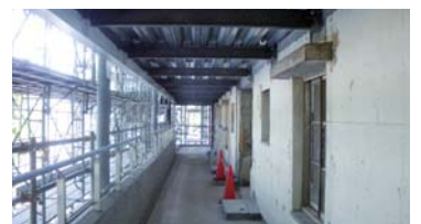
6 コンクリート打設後のスラブ下端面
