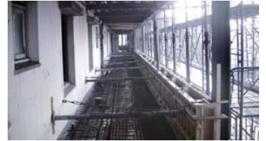
6 2階スラブ配筋、型枠建込み
