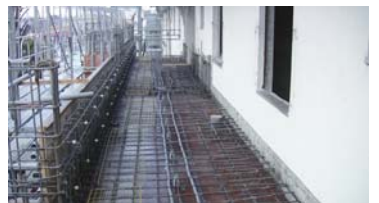
6 スラブ・手摺の配筋
