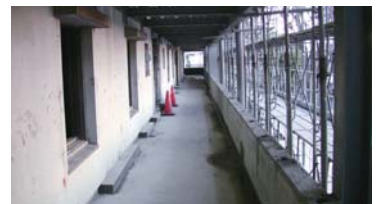
7 コンクリート打設後
