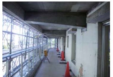
6 コンクリート打設後のスラブ下端面
