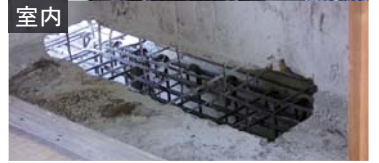
3 新設片持ち梁の配筋
