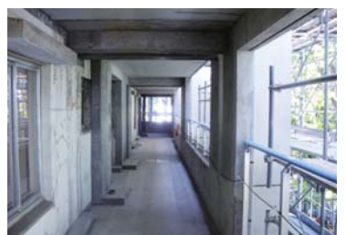
7 コンクリート打設後
