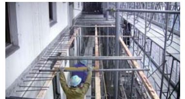
4 鉄骨工事(鉄骨柱建方)後
