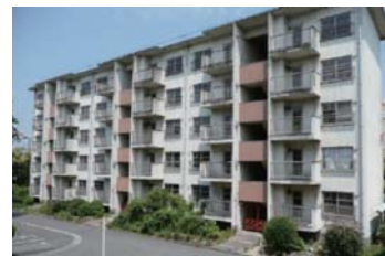
RCラーメン構造棟
