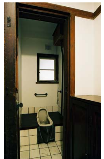
写真 当時は珍しかった水洗便所
