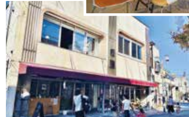
kanuma commons (既存建物リノベーション)
