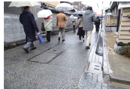
築地塀通りの電線類地中化と道路修景整備：無電柱化と石畳調の舗装が、シンボルの築地塀（練壁）や歴史的景観を美しく見せる。
