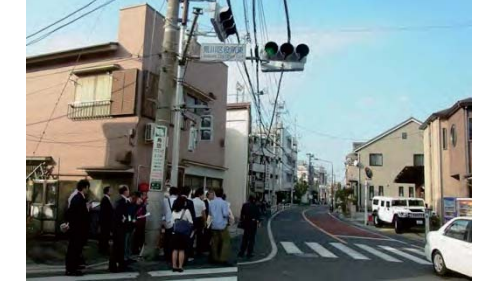
特定整備路線（1.2km にわたり 25m（現在 4～11m）に拡幅され、沿道の緑道整備と耐火建築への建替え促進により延焼遮断帯としての機能も合わせ持つ）
