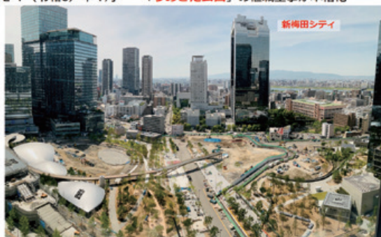
2024（令和6）年4月 「うめきた公園」の植栽工事が本格化
