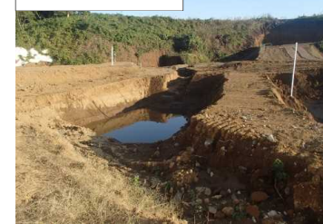
④仮設沈砂池-2
