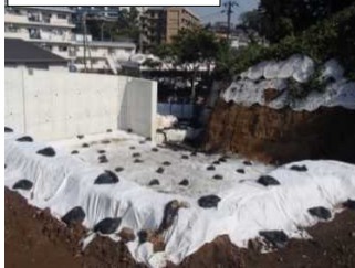
②掘削面保護
