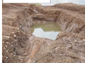
④仮設沈砂池-1
