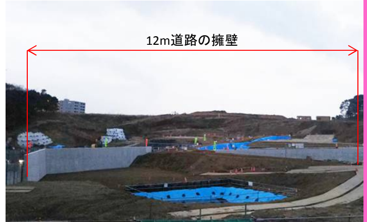
擁壁施工状況
