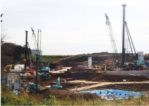
擁壁基礎杭施工状況
