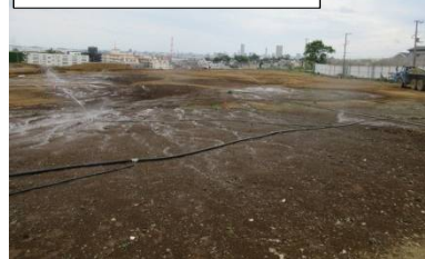
スプリンクラーによる散水
