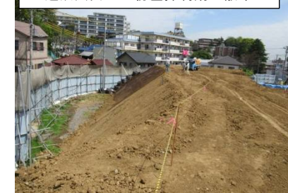
造成法面への粉塵抑制剤の散布
