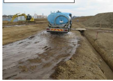
散水車による散水
