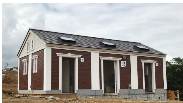
防災公園内トイレ
