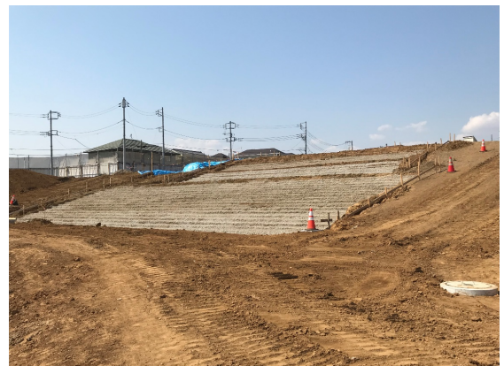
3月の工事状況
