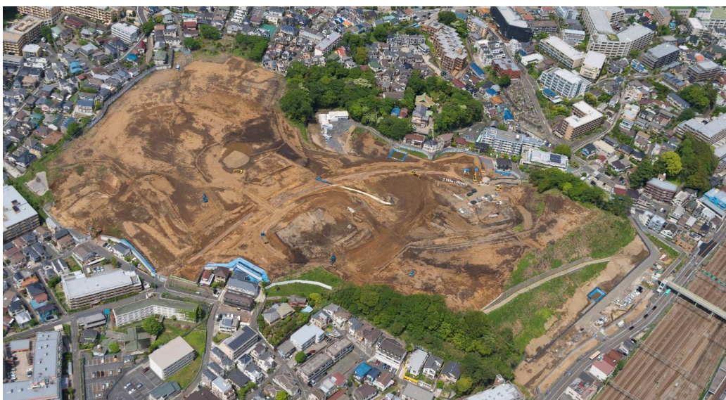
工事区域全体
