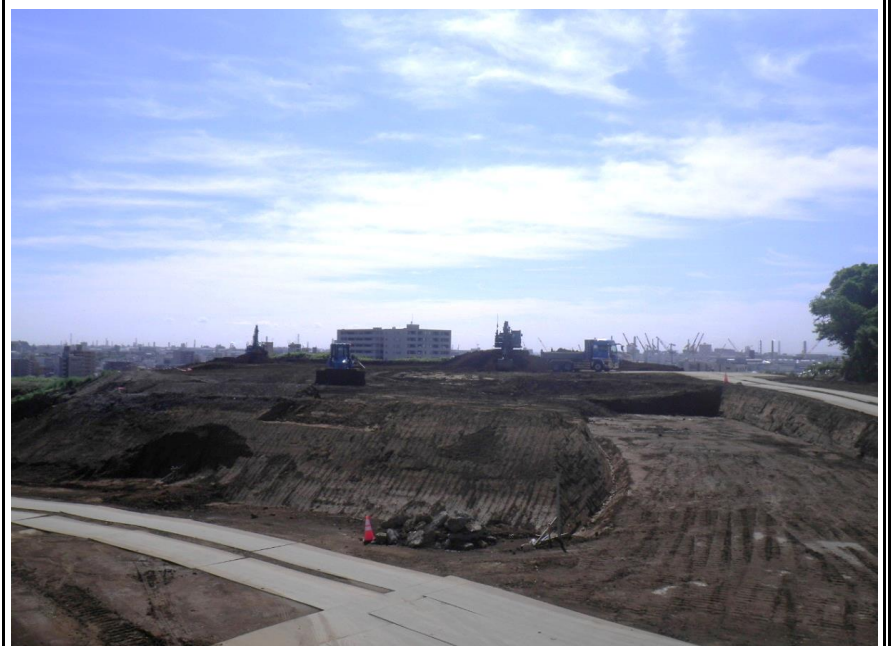
土工事状況(切土部)
