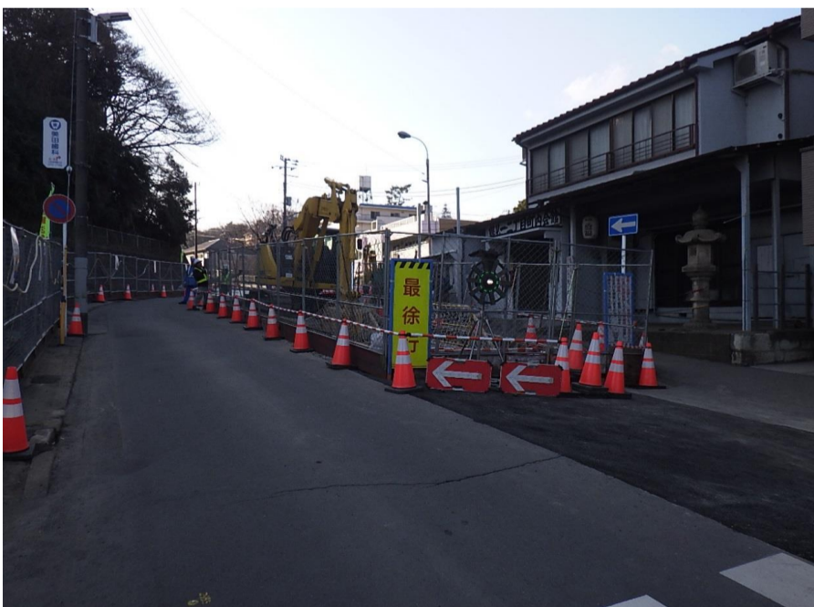
下水道工事状況
