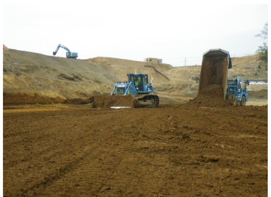
盛土敷均し転圧状況
