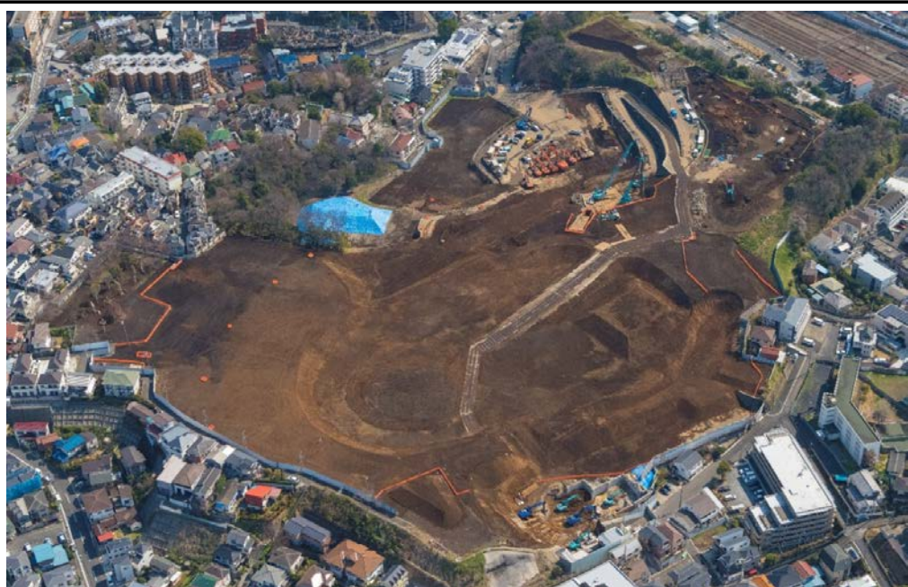
建物の解体状況
