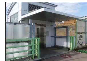
エレベーター
