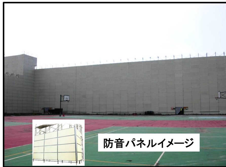
防音パネルによる養生状況(参考イメージ写真)
