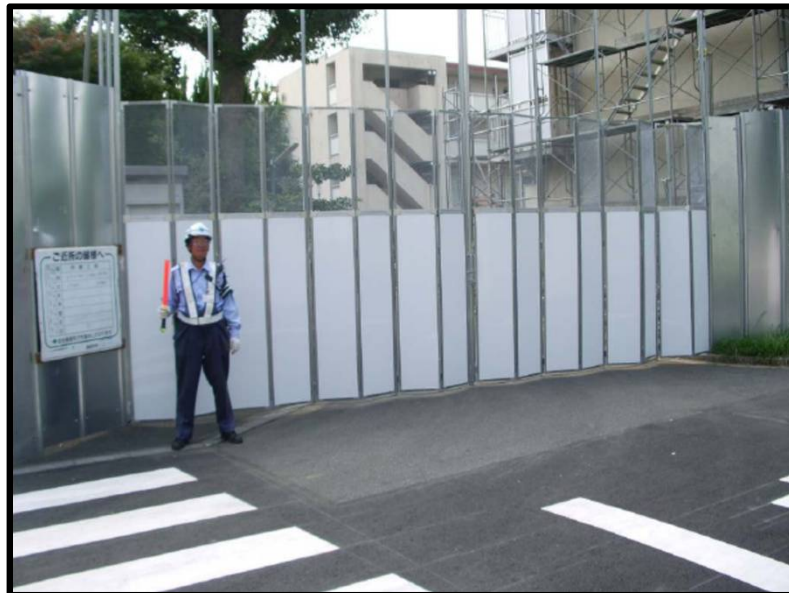
工事車両出入口及び誘導員配置 (参考イメージ写真)
