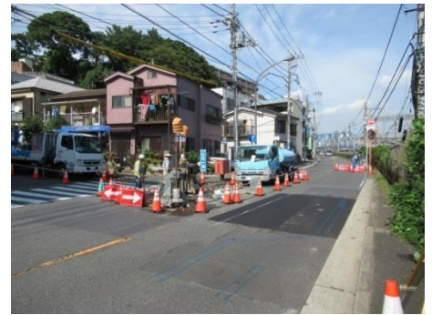
下水道工事状況
