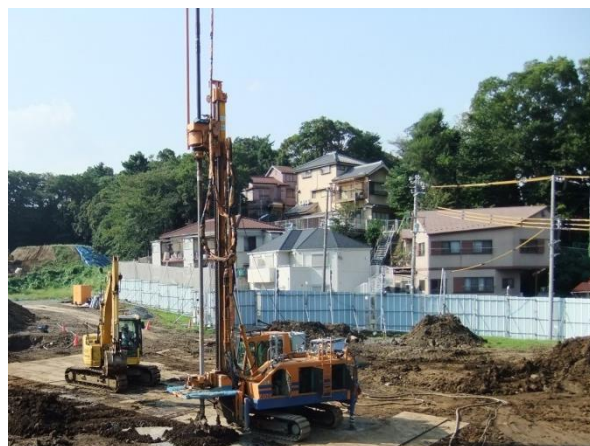
地盤改良施工状況
