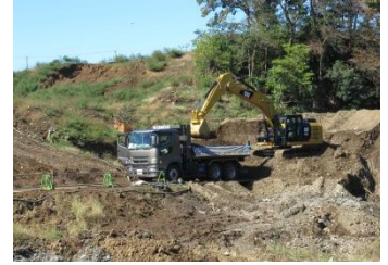
土砂搬出状況
