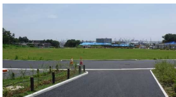
写真① 北側道路付近の入口
