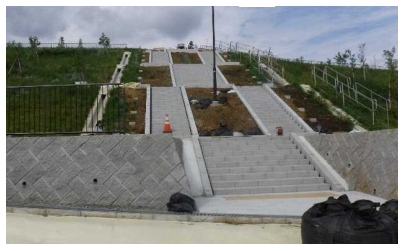
写真② 西側道路付近の入口
