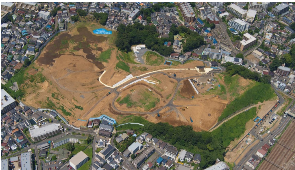
工事区域全体
