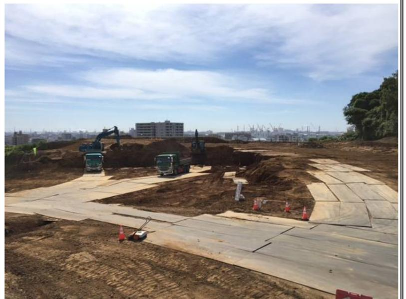
梅雨が明けて真夏のカラカラ天気になると、砂埃が現場の大敵です。散水車及び作業員によるホース散水ならびに防災公園はスプリンクラーを増設して砂埃を抑制します。
