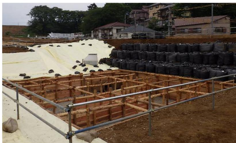
切土・盛土工事で重機走行が増えてまいります、防塵・騒音・振動に十分配慮した作業を進めてまいります。またダンプトラックは現場走行路を使用し、安全第一で走行してまいります。
