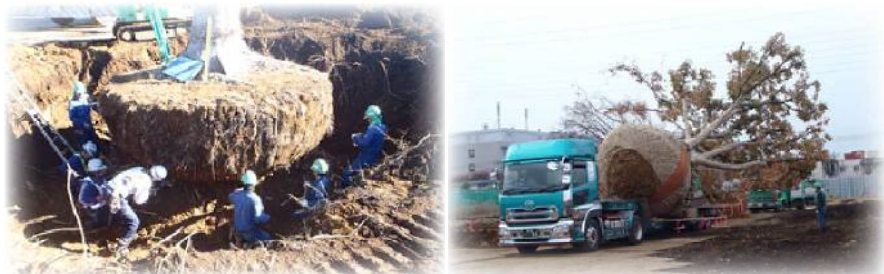
移植木の掘り取り状況
