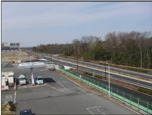
国営公園西線（平成 29 年 4 月 5 日撮影） 昭島ガス(株)さま本社屋上から北方向を撮影
