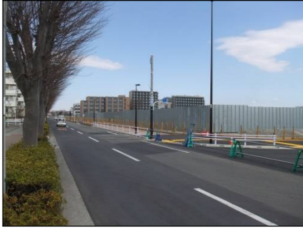
道路開放前の様子（平成 29 年 3 月下旬撮影）
