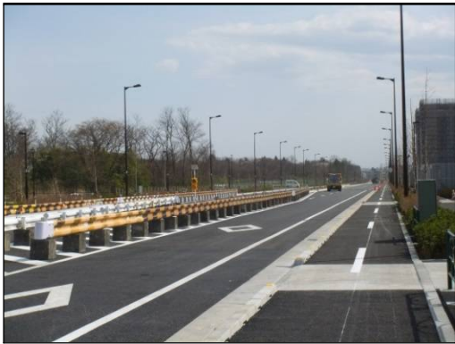
国営公園西線（平成 29 年 4 月 6 日撮影） 配水場付近から南方向を撮影（写っている車両は、 作業車両）
