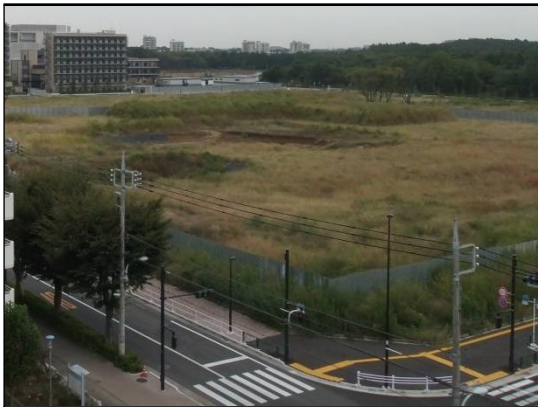
最後の宅地整備箇所（平成 29 年 10 月 2 日撮影） 平成 29 年 3 月 29 日掲載の「立川基地跡地昭島地区における道路開放などのお知らせ」においてご案内いたしましたように、宅地の造成作業中に、一部箇所にて地中障害物が埋設されていることが確認されたため、工事を一時中断しておりました。
