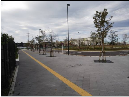
交通広場（平成 29 年 1 0 月 3 1 日撮影） 交通広場南東端（歩行者専用道路付近）から 西方向を撮影
