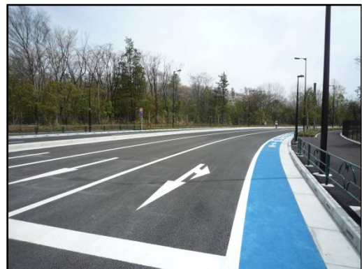
国営公園南線・道路開放直前 国営公園西線との交差点付近から東南東方向 を撮影
