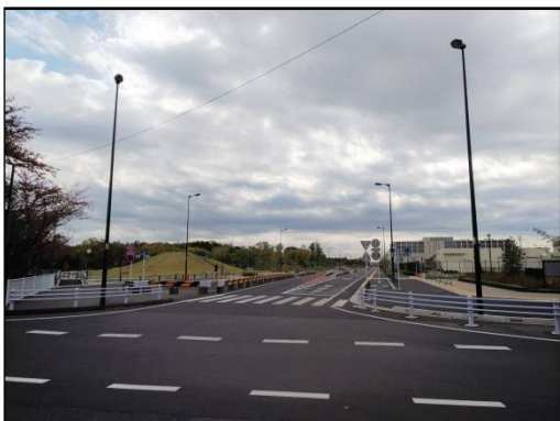
国営公園西線（平成 29 年 1 0 月 3 1 日撮影） 地区北側の交差点から南方向を撮影
