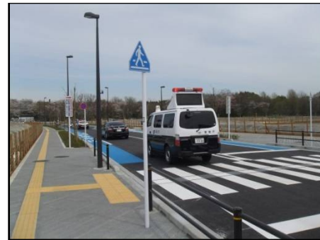
区画道路4号線及び交通広場・道路開放 交通広場入り口付近から北方向を撮影 交通広場を一周し、区画道路4号線を北上して、道路開放は完了しました。
