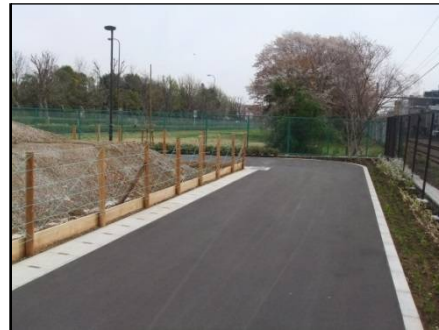
歩行者専用道東端部付近 （突き当りを左へ行くと、都道 153 号線の歩道）
