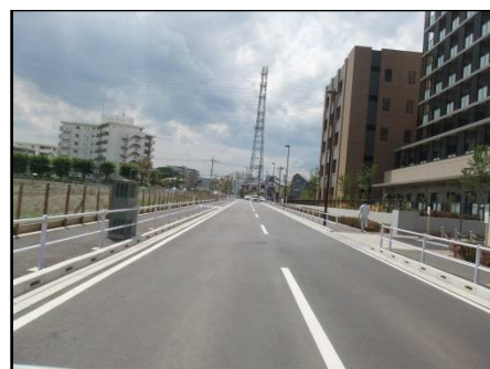
道路開放後の様子（平成 29 年 5 月上旬撮影）
