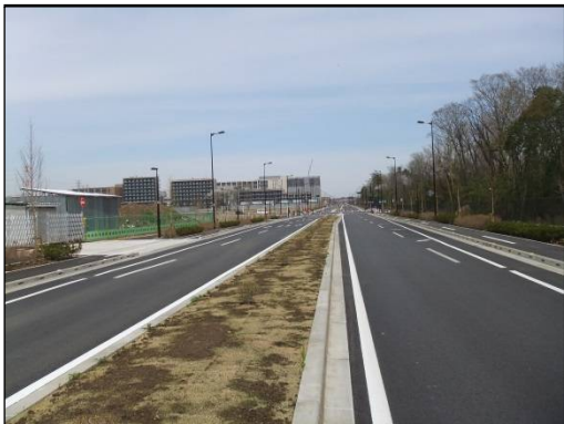
国営公園西線・開放直前 昭島ガス(株)さま本社付近から北方向を撮影
