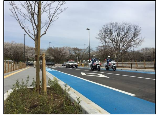
区画道路4号線及び交通広場・道路開放 区画道路4号線上から北方向を撮影
