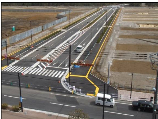
国営公園南線(平成29年3月24日撮影) 市道昭島6号線(富士見通り)との交差点付近から東方向を俯瞰で撮影 (写真中央付近の車両は、作業車両)
