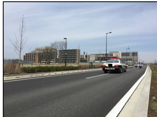
国営公園西線・道路開放 国営公園南線との交差点の北側から北方向
