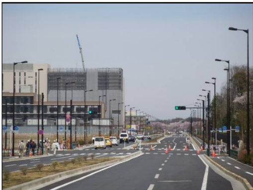
国営公園西線・道路開放 昭島ガス(株)さま本社付近から北方向を撮影
