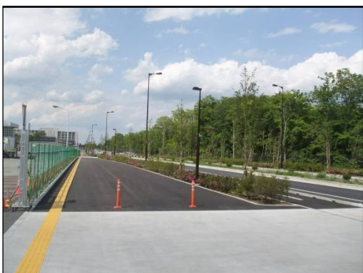
国営公園西線（平成 29 年 5 月 1 1 日撮影） 昭島ガス㈱さま本社前から北方向を撮影
