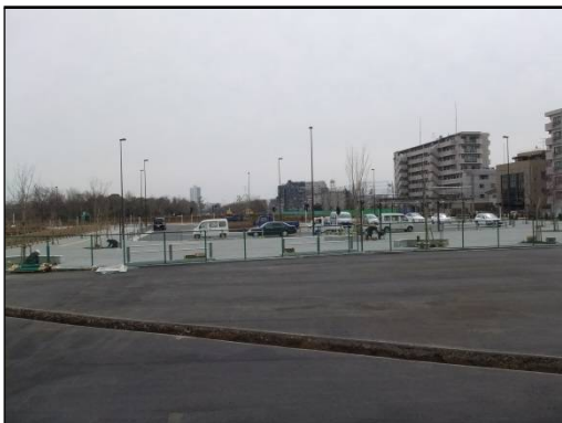
交通広場（平成 29 年 3 月 23 日撮影） 福島通り沿いから交通広場を撮影 交通広場に停車中の車両は、作業用車両です。 なお、手前のアスファルト敷きの部分は、東京都が行う道路整備のための用地となります。
