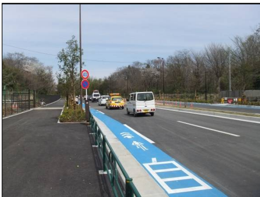
国営公園南線・道路開放 既存の都道 1 5 3 号線との接続部付近から北 方向を撮影
