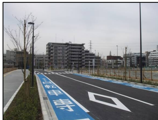
区画道路4号線及び交通広場・開放直前の様子 区画道路4号線上から南方向（交通広場）を撮影
