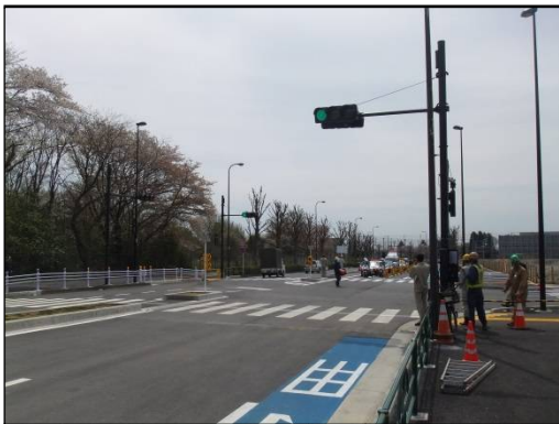
国営公園南線・開放準備 新設された信号に火が入ったところ
