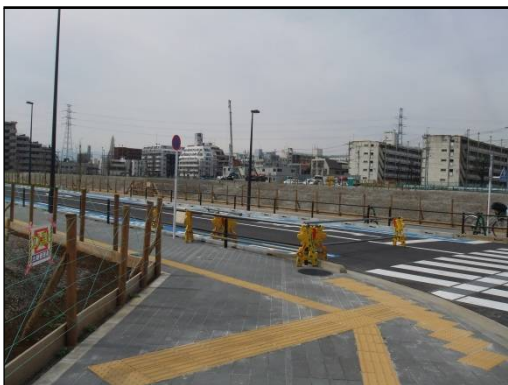
区画道路4号線及び交通広場・開放直前の様子 区画道路3号線南側の歩道上から区画道路4号線を撮影 見えにくのですが、この時点では、交差点付近には、まだ柵が置かれていました。
