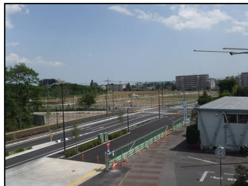
国営公園西線（平成 29 年 5 月 1 1 日撮影） 昭島ガス㈱さま本社屋上から南方向（昭和記念公園西交差点）を撮影
