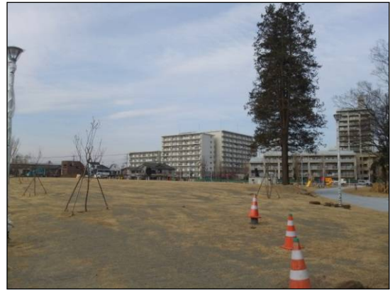
2号公園芝生広場（平成29年2月22日撮影・工事中）
