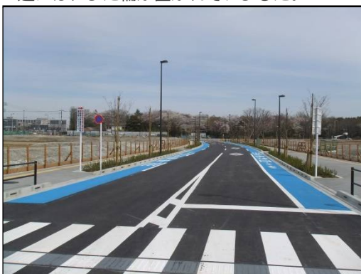
区画道路4号線及び交通広場・開放直前の様子 交通広場から北方向（区画道路4号線）を撮影 柵を取り外したところです。
