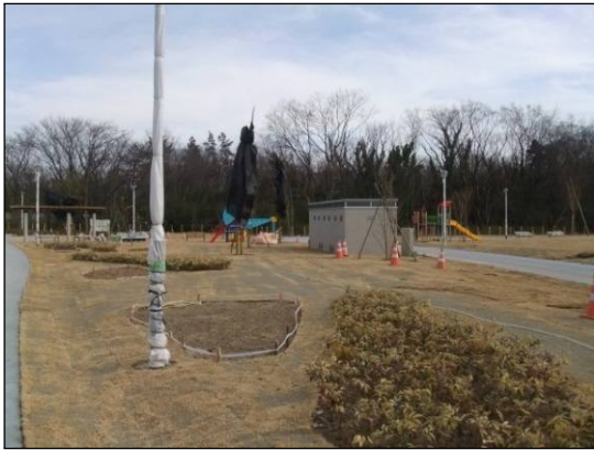
2号公園遊具（平成29年2月22日撮影・工事中）
