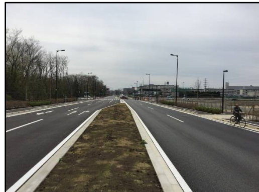
国営公園西線・開放直前 国営公園南線との交差点の北側から南方向を 撮影（南線では既に一般車両が通行中）
