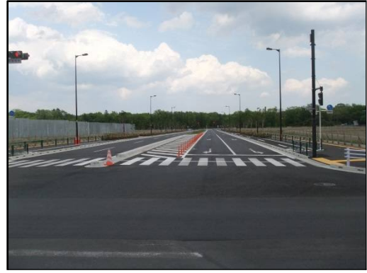
国営公園南線（平成 29 年 5 月 1 1 日撮影） 市道昭島 6 号線（富士見通り）との交差点部から東方向を撮影（中央のゼブラゾーンは、将来、左折レーンを設けるスペースです。）
