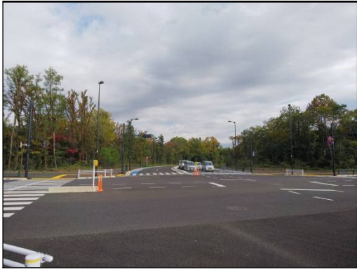
国営公園南線（平成 29 年 10 月 31 日撮影） 国営公園西線との交差点付近から東方向を撮影
