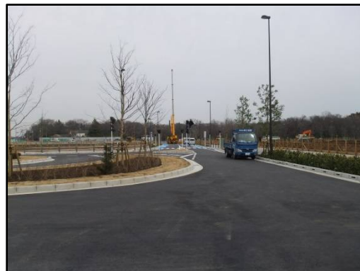
交通広場（平成 29 年 3 月 23 日撮影） 交通広場内から北方向（区画道路4号線）を撮影 交通広場に停車中の車両は、作業用車両です。
