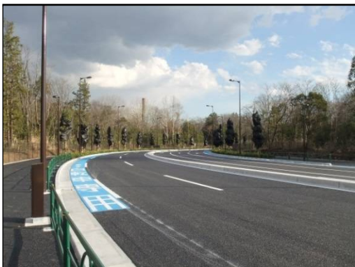
国営公園南線(平成29年1月撮影) 国営公園西線との交差点付近から東南東方向を撮影
