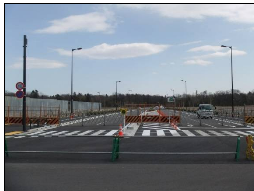
国営公園南線(平成29年3月24日撮影) 市道昭島6号線(富士見通り)との交差点から東方向を撮影 (写っている車両は、作業車両)
