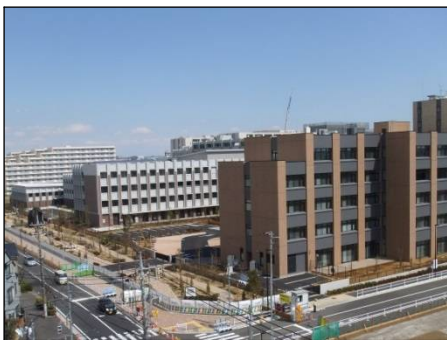
道路開放前の様子（平成 29 年 3 月下旬撮影） 【区画道路 2 号線】
