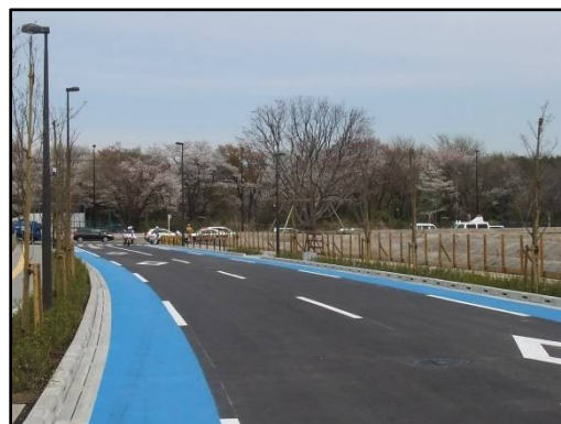
区画道路4号線及び交通広場・道路開放 区画道路4号線上から北方向を撮影 交差点（丁子路）から、警察の車両が入ってくるところです。 なお、区画道路4号線及び交通広場の開放が最後になります。
