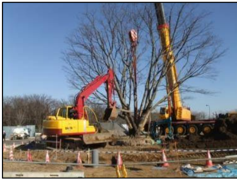
樹木移植作業⑦ 埋戻し作業の状況
