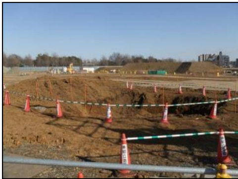
樹木移植作業① 移植先の準備
