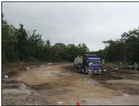
⑤国営公園南線（9月） 歩道・車道整備状況（工事中）
