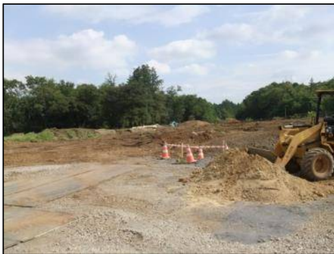
①公園用地内整備（9月） 造成工事実施状況
