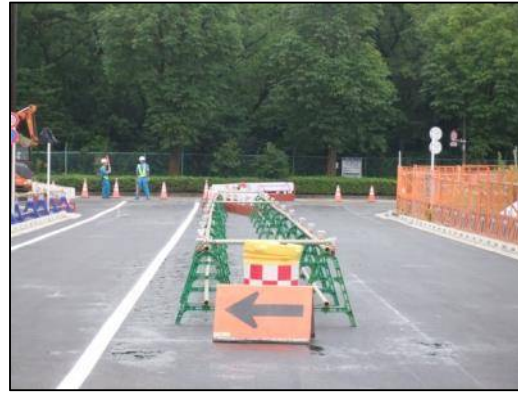
切替作業④ 都道 153 号線との交差点の状況。
