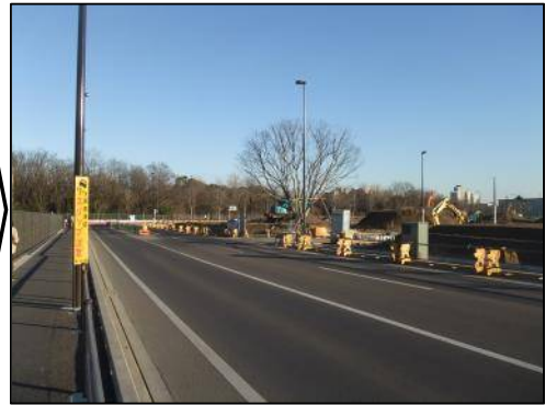
④区画道路3号線整備状況（1月） （道路開放済み）
