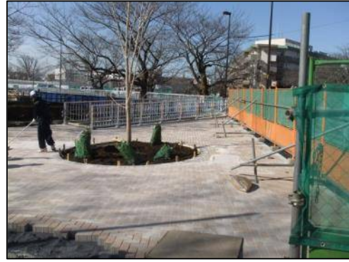
⑨' 仮設人道橋架橋状況（1月） 2号公園の入口広場部整備状況 （工事中）
