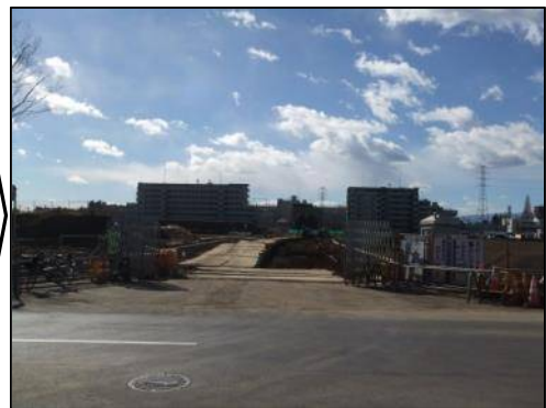
②駅前街区整地状況（12月） 区画道路3号線から南方向を撮影。
