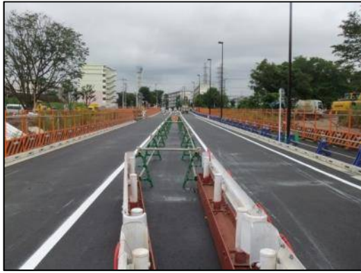
切替作業③ 切替直前の様子
