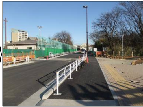
②区画道路整備状況（1月） （完成）
