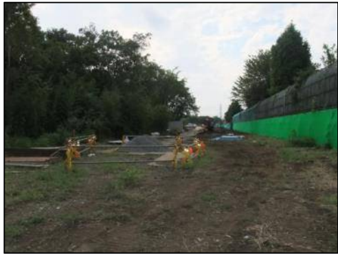
③区画道路予定地整地状況（9月） （既存樹木伐採後）
