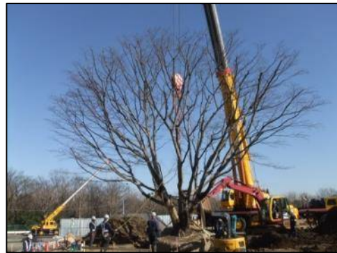
樹木移植作業② 仮移植先からの運搬。
