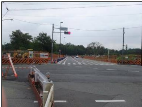
⑤区画道路3号線整備状況（9月） （道路開放済み） （左のB型バリケードの奥は旧道）
