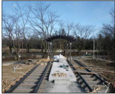
【3号公園廃線遺構 (1月下旬)】 旧・陸軍航空工廠への引込線の遺構
