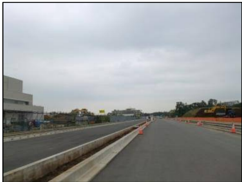
① 国道公園西線 (9月) 車道整備状況 (工事中)
