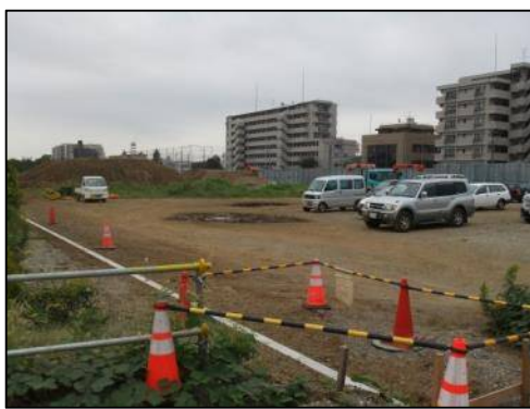
①交通広場予定地整地状況（9月）
