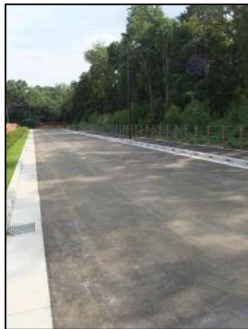
④区画道路整備状況（2号公園東側）（9月） （整備中）
