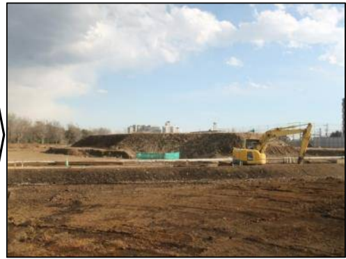
③駅前街区整地状況（12月）
