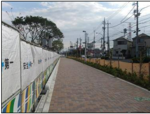
⑦富士見道り沿いの歩道（9月） 歩道及び植栽の整備状況（工事中）
