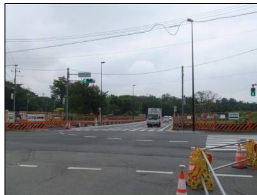
切替作業⑧ 解放後の様子
