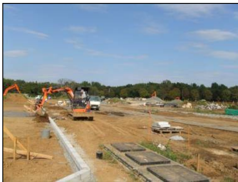
②駅前街区整地状況（9月） 交通広場予定地から北方向を撮影
