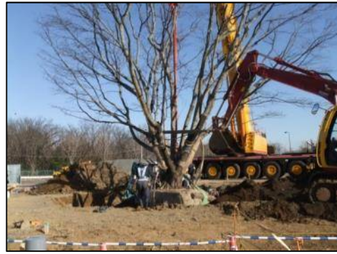
樹木移植作業⑥ 据付作業の状況
