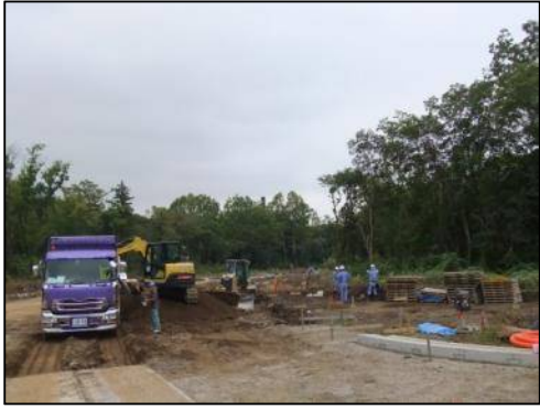
⑥国営公園南線（9月） 歩道・車道整備状況（工事中）
