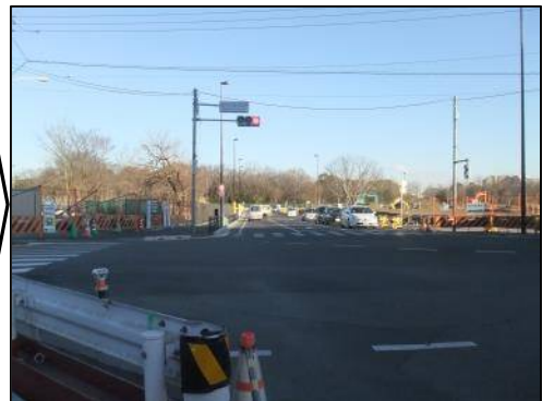
⑤区画道路3号線整備状況（1月） （道路開放済み）
