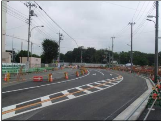
切替作業⑨ 解放後の様子（9月） 南側（福島通り）から交差点を撮影。
