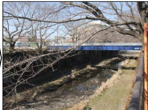
⑨仮設人道橋架橋状況 (12月) (工事中)
