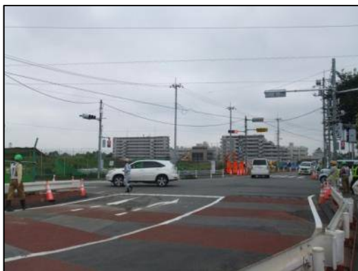
切替作業① 切替直前の昭和記念公園西交差点 昭島ガス本社前より南方向を撮影 信号の手前側が仮設の迂回路です。
