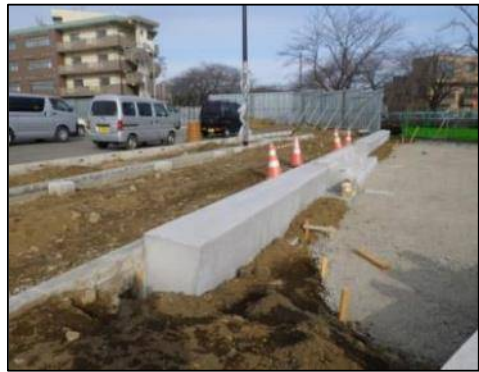
【3号公園 (1月下旬)】 コンクリートウォールの築造状況。
