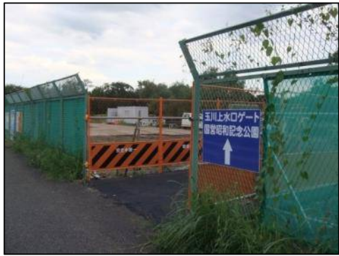
⑥遊歩道への仮設通路 (仮設通路設置状況)
