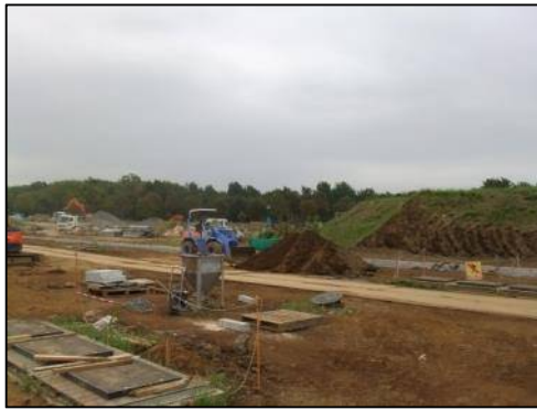
③駅前街区整地状況（9月）
