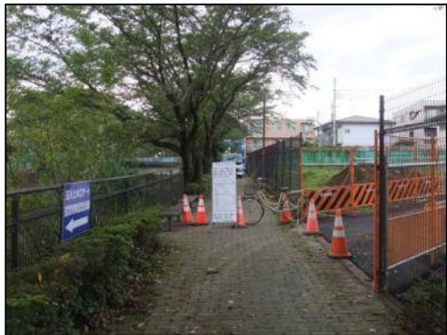
⑧遊歩道への仮設通路 (9月) (仮設通路設置状況)
