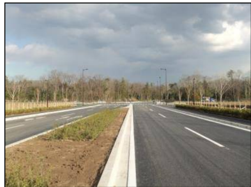
④' 国営公園南線（12月） 歩道・車道整備状況（完成）
