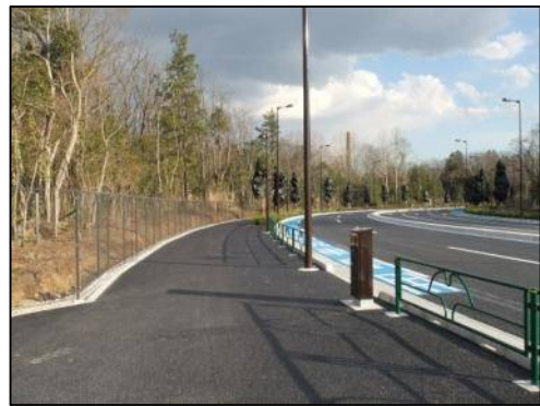
⑤国営公園南線（12月） 歩道・車道整備状況（完成）
