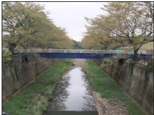
⑨仮設人道橋架橋状況 (9月末) (設置作業中)
