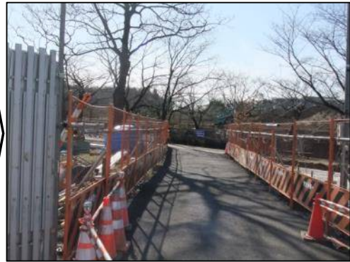
⑦遊歩道への仮設通路 (12月)
