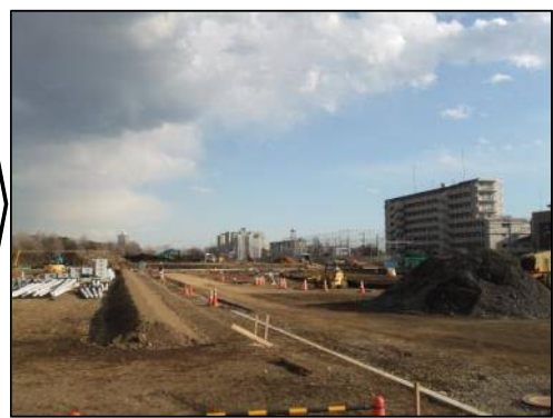
①交通広場予定地整地状況（12月）
