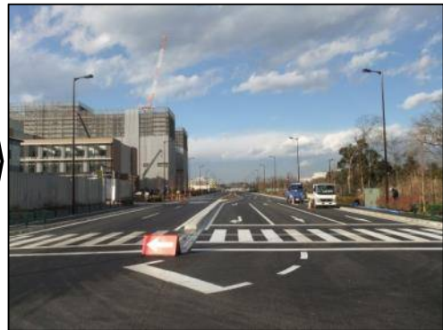
① 国道公園西線 (12月) 車道整備状況 (完了)
