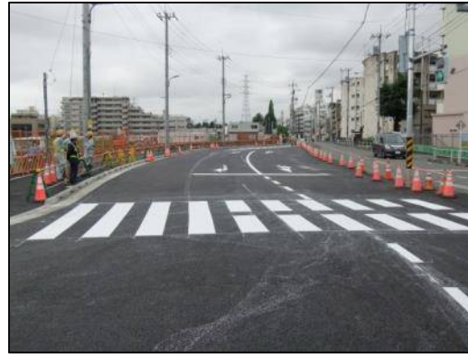
切替作業⑥ 切替直前の様子 交差点から南方向を撮影。
