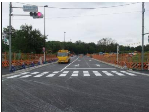
切替作業⑦ 切替直前の様子
