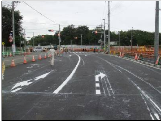
切替作業⑤ 切替直前の昭和記念公園西交差点南側（福島通り）から交差点を撮影。福島通りは、東京都による整備が予定されていますが、北側の道路（工事中）の線形に併せ、交差点付近の擦り付けを変更しました。
