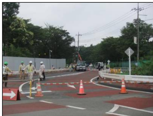
切替作業② 切替直前の仮設迂回路 仮設迂回路より東方向を撮影
