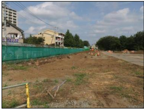
②区画道路予定地整地状況（9月） （造成作業中）
