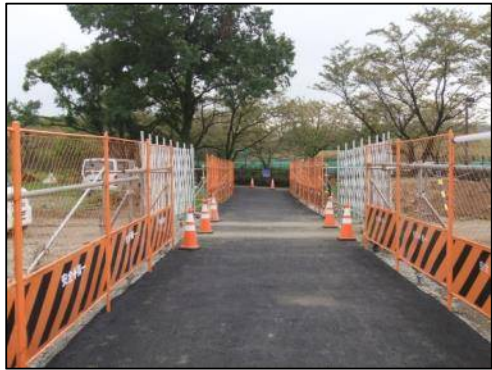
⑦遊歩道への仮設通路 (9月) (仮設通路設置状況)
