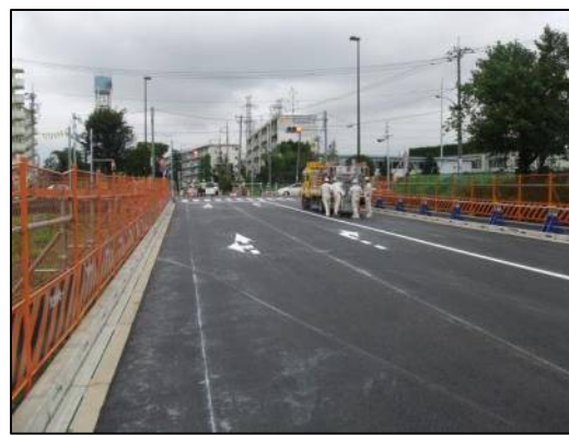
切替作業② 切替直前の昭和記念公園西交差点 (白線の設置状況)
