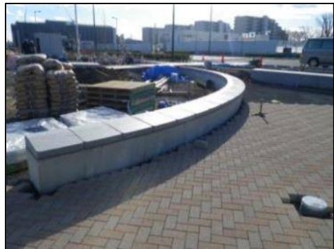
【3号公園 (1月下旬)】 ベンチウォールの設置・インターロッキング舗装の状況
