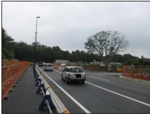
④区画道路3号線整備状況（9月） （道路開放済み）
